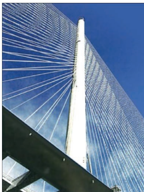
Рис. 1. Главная башенная опора моста Стоункаттерс, поднимающаяся более чем на 175 м над уровнем моря (Гонконг)
