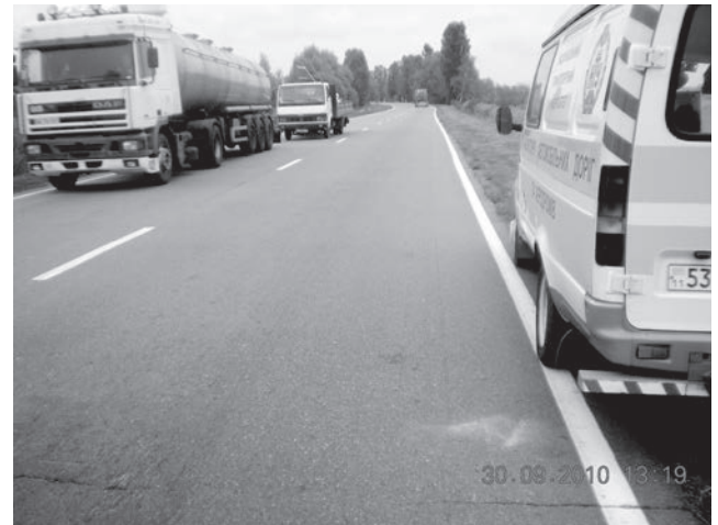
Рис. 7. Опытный участок дороги
