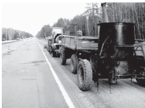
а) место проведения работ
