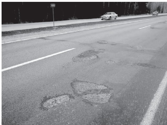
Рис. 16. Внешний вид участка ремонтируемой дороги через неделю после ремонта
