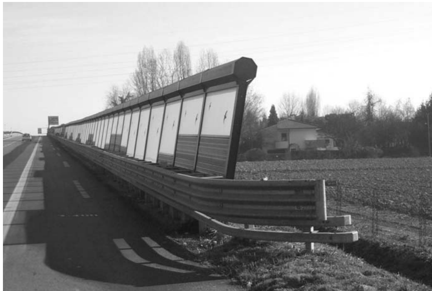
Рисунок 4 – Шумозахисний екран із звукопоглинальною кромкою спеціальної форми
