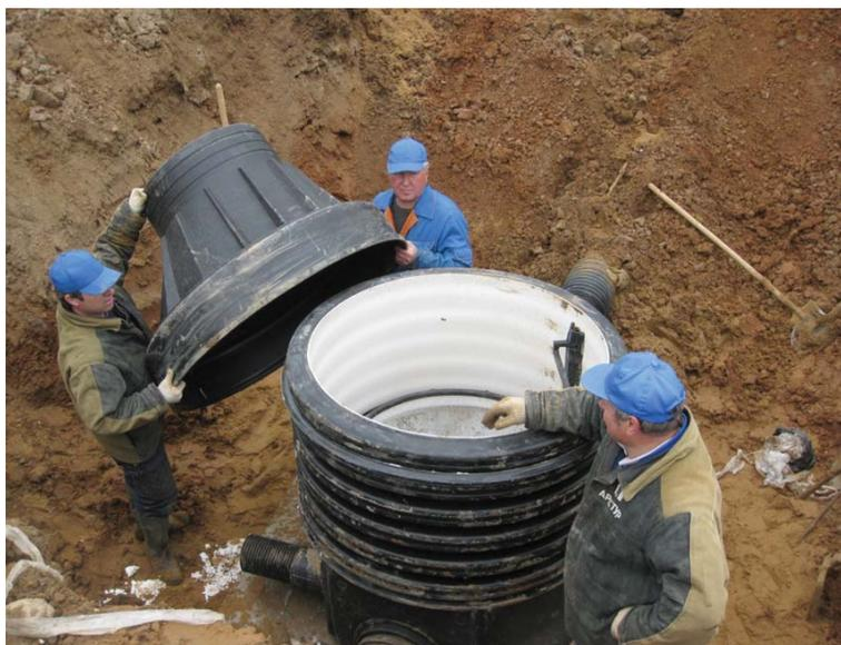
**Рисунок 1.** Смотровой колодец, выполненный из элементов полиэтиленовой трубы
