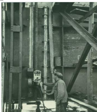
Зварювання вертикальних швів автоматом А-314
