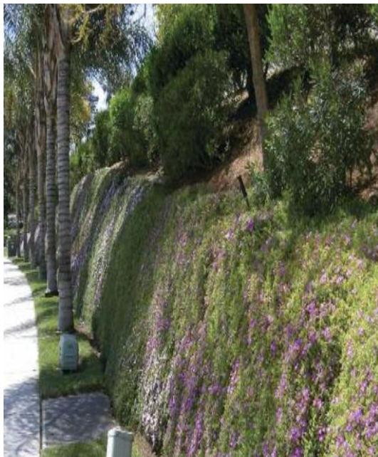
Рис. 1. Пример озеленения одевающих (прижимных) подпорных стен (ландшафт приближен к естественному)
