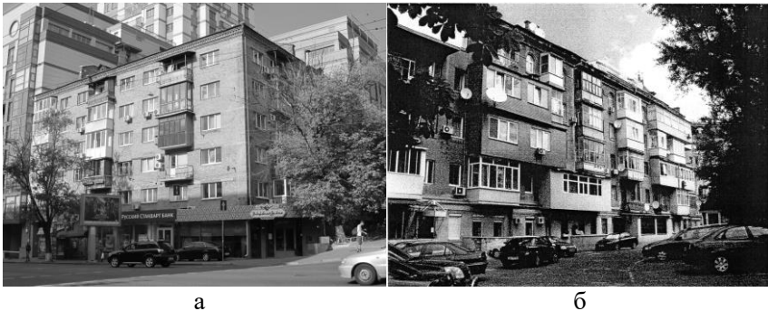
Рис. 1. Кам'яні житлові будівлі, що розглядаються: а) по вул. Саксаганського, 70/16; б) по вул. Гончара, 67
