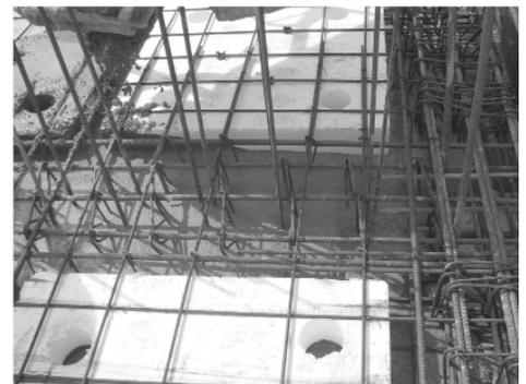
Рис. 9. Плоские плиты с вкладышами в виде прямоугольных пенополистирольных призм
