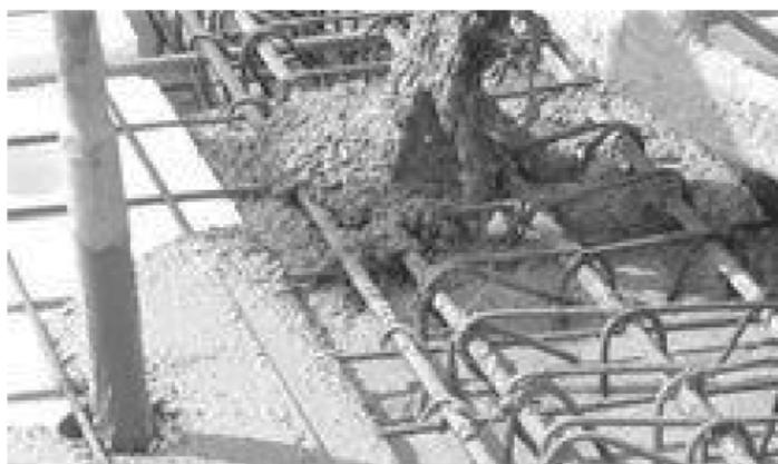
*Рис. 10. Контроль заполнения бетонной смесью нижней зоны плиты перекрытия с пустотами в виде призм пенополистирола*
