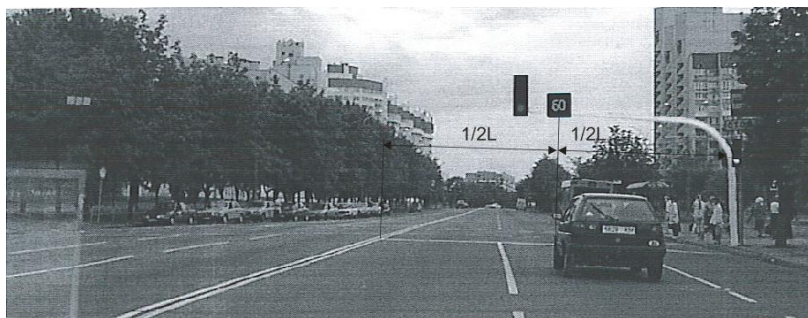
Рисунок 2 – Схема установки УСК на выносной консоли над трехполосной проезжей частью одного направления
