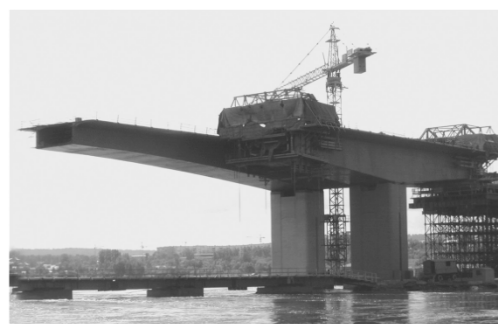
б). Навесное бетонирование. Нарращивание консолей в направлении середины пролета навстречу друг другу.
