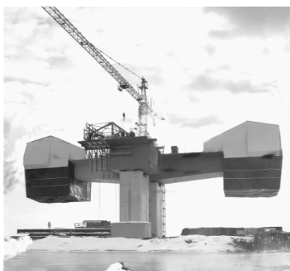
а). Начальные стадии сооружения пролета. Уравниваемое навесное бетонирование с промежуточной опоры.
