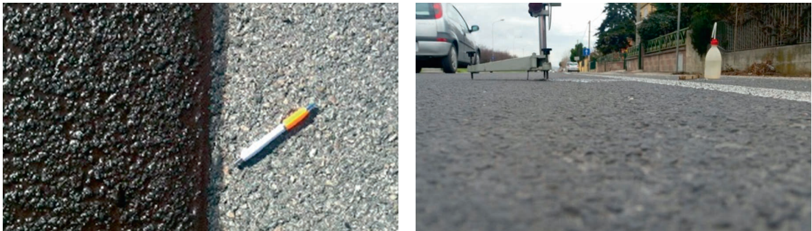
Рисунок 1 — Приклад влаштування захисного шару зносу з ЛЕМС в Італії
