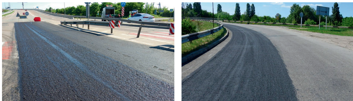
Рисунок 2 — Улаштування захисного шару зносу з ЛЕМС на автомобільній дорозі Н-03 Житомир — Чернівці (км 190 — км 192)
