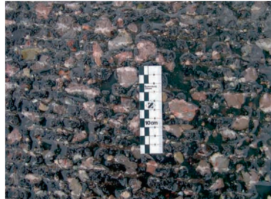
Рисунок 2 — Підготовка поверхні існуючого покриття до вкладання шару цементобетону при застосуванні методу «зрощування»
