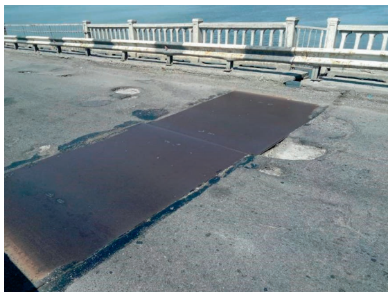
Рисунок 2 — Руйнування покриття, деформаційного шва і секцій перил на мосту через р. Сула на км 170+867 автомобільної дороги Н-08 (стан до ремонту). Наразі відбувається капітальний ремонт мосту
