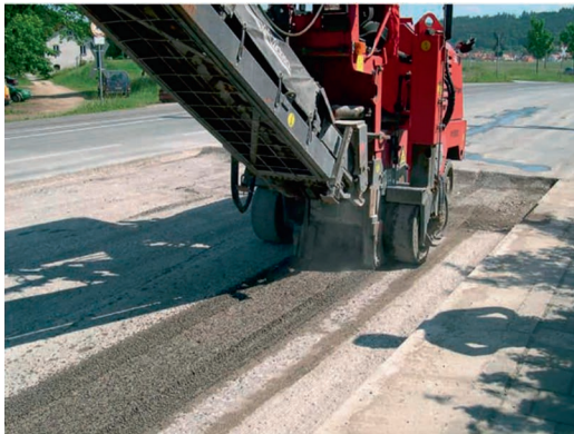
Рисунок 2 — Підготовка поверхні існуючого покриття до вкладання шару цементобетону при застосуванні методу «зрощування»
