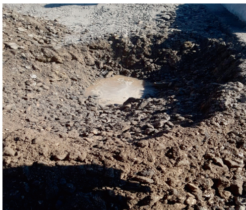
Рисунок 3 — Вода у ґрунтовій основі дорожнього одягу при влаштуванні шурфу
