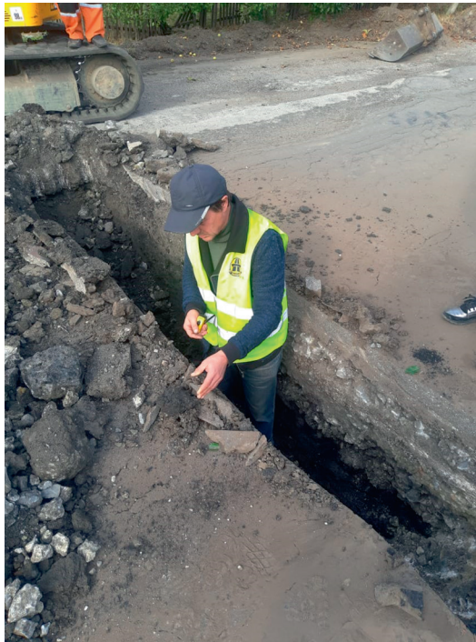
Рисунок 5 — Дослідження у шурфу матеріалів існуючого дорожнього одягу
