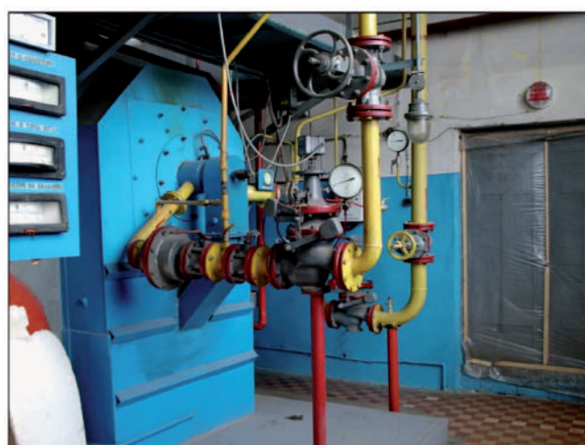
Рисунок 2 – Совместное сжигание природного газа и биогаза в промышленном котле
