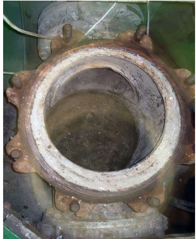
Рис. 6. Корпус фільтра
