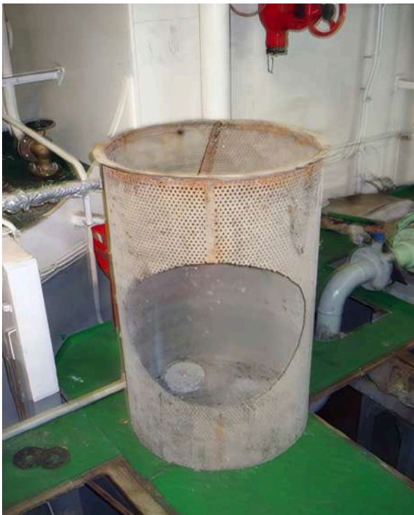
Рис. 5. Сітчастий фільтр
