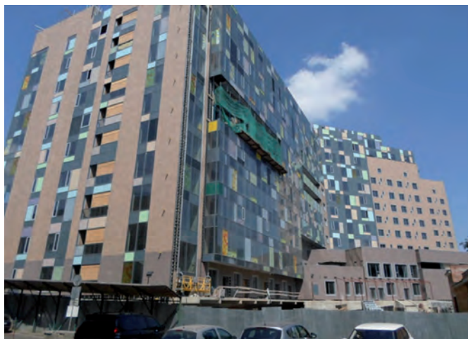
Рис. 12 Загальний вигляд нової будівлі Національної дитячої спеціалізованої лікарні «Охматдит».
