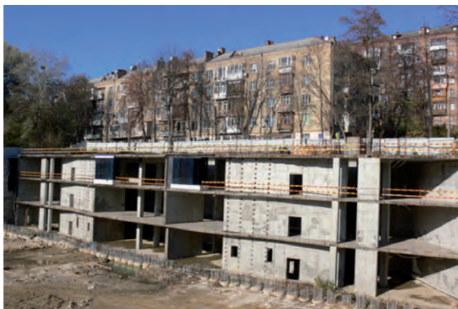
Рис. 10 Конструкції каркасу етажерки стилобату.
