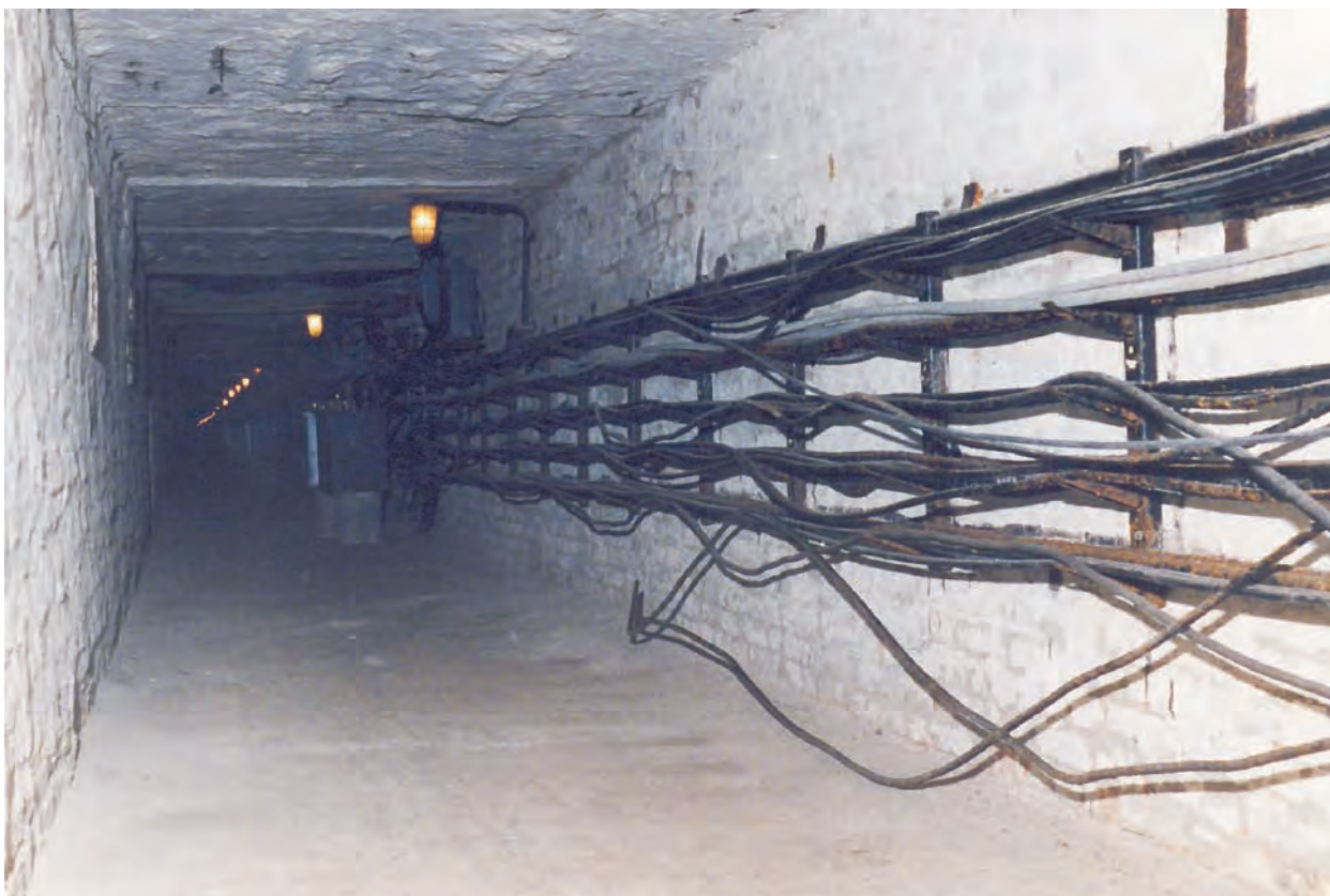
Рис. 14. Підземний колектор радіотелескопа УТР-2
