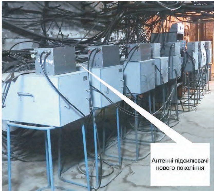
Рис. 12. Комплект нових 3-смугових антенних підсилювачів четвертого ярусу радіотелескопа УТР-2
