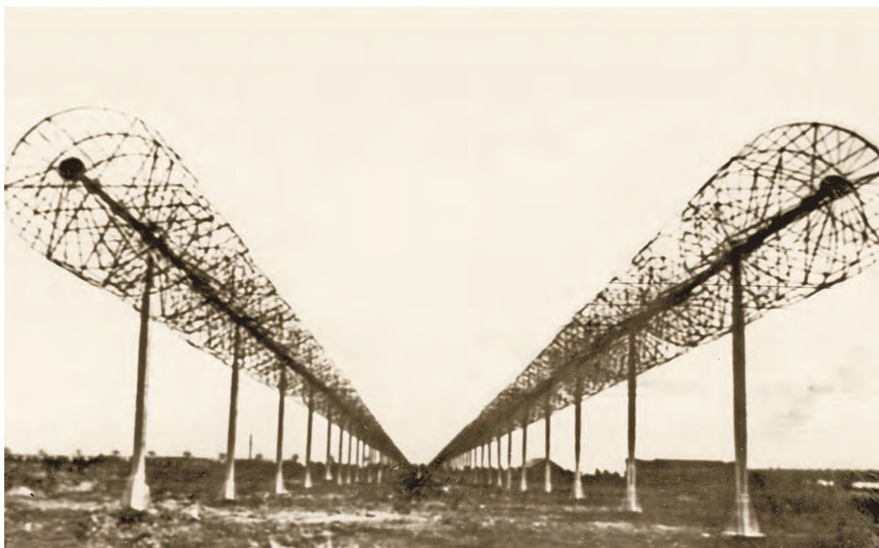
Рис. 4. Антени Північ–Південь і Схід–Захід радіотелескопа УТР-1 діапазону 10 \div 25 МГц – першого Т-подібного радіотелескопа у Європі
