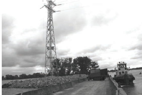
Рисунок 8. Замена проводов в переходном пролете 19–20: а) демонтаж проводов; б) опрессовка новых шлейфов; в) раскатка провода с опусканием на воду с применением поплавков; г) поданкеровка провода на переходной опоре.
