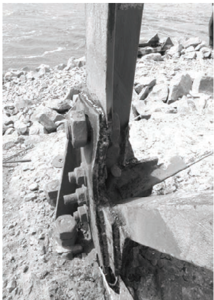
Рисунок 5. Усиление конструкций опор перехода ВЛ: а) увеличение сечения поясов; б), г) усиление фундаментов пригрузочными монолитными ростверками; в) локализация мест щелевой коррозии с обваркой узлов.
