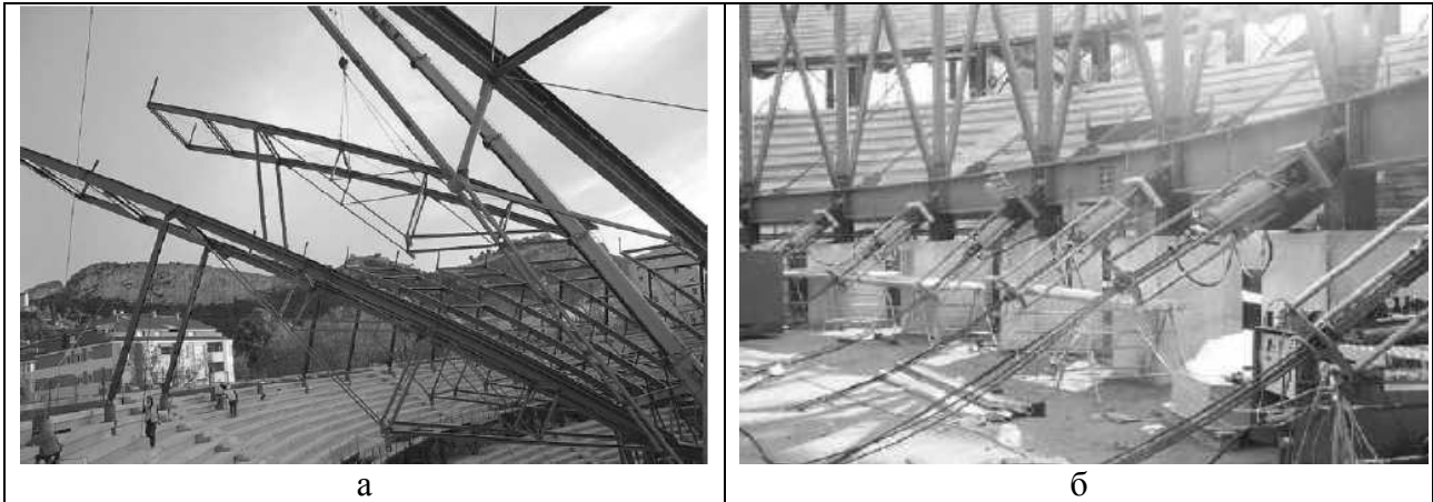
Рис.8. Елементи куполу перед початком підйому:
