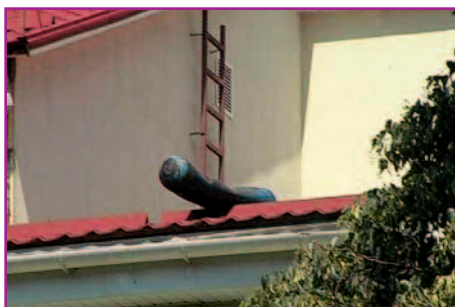
Фото 4. Пустой баллон из контейнера, отброшенный силой взрыва на крышу двухэтажного административного здания (расстояние более 100 м)
