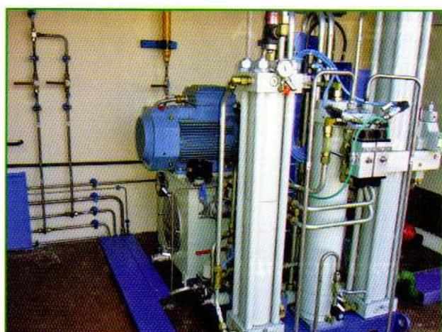
Фото 1. Вид на гидропоршневой компрессор, размещённый на АГНКС БИ-70
