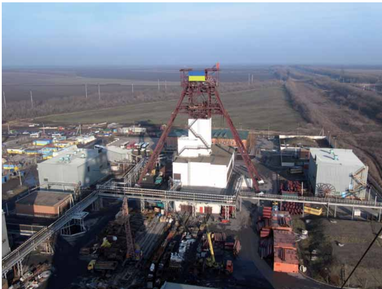
Площадка блока № 10 ПАО «Шахтоуправление «Покровское».
