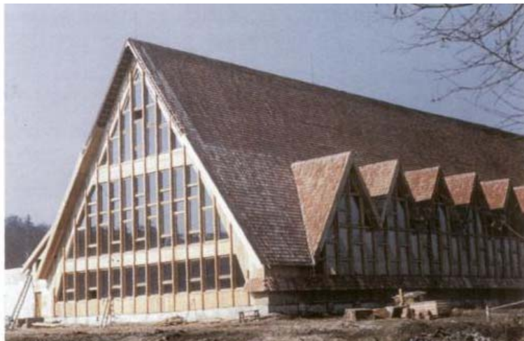
Рис. 2. Будівля кінноспортивного манежу у м. Каунас
