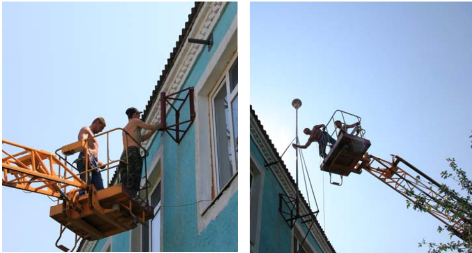
Рис. 2. Монтування конструкції опори
