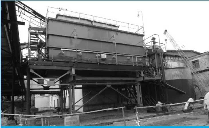
Станція в процесі монтажу та обв'язки трубопроводами
