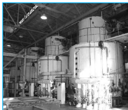
Випарна станція (Яготинський цукровий завод)
