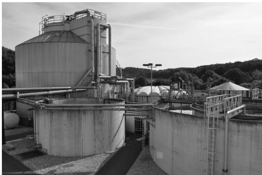
Рис.1. Метантенк та реактор гідролізу
