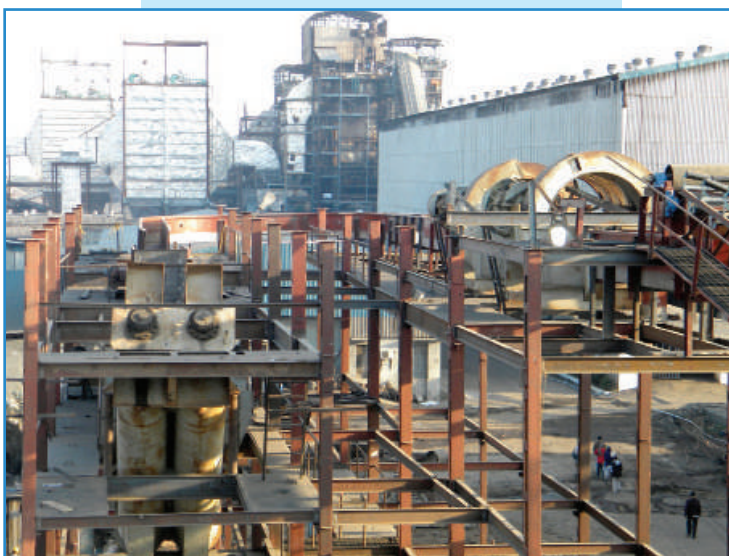
Установка металлоконструкций компанией «САХАВТОМАТ». Начало монтажа оборудования
