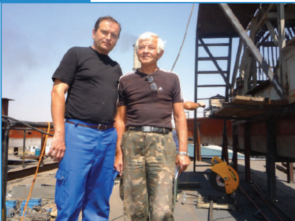
Инженер-наладчик электрооборудования компании «САХАВТОМАТ» Валентин Петрович Колесник и Юрий Григорьевич Желтяков на стройплощадке
