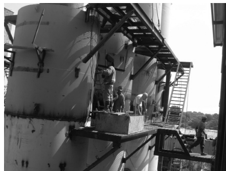
Монтаж станції дефекосатураційного очищення дифузійного соку
