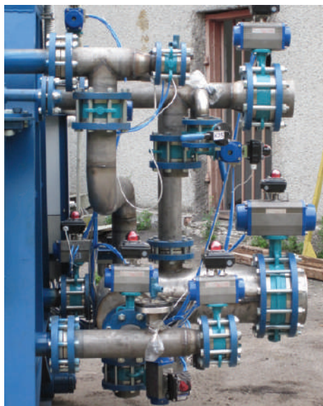
Клапанно-коллекторная система
