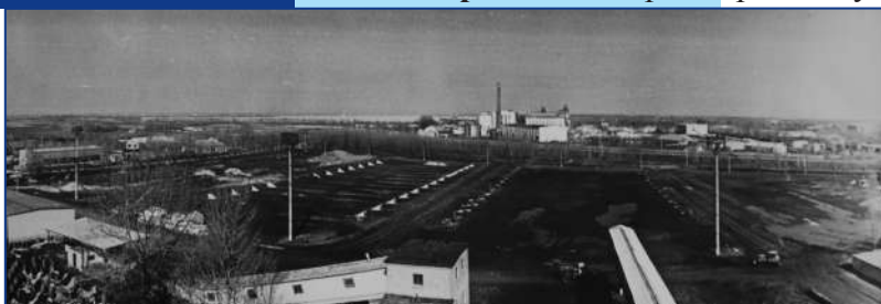
Промплощадка будівництва котельно-складального цеху. Розпочаті земляні роботи. Квітень 1976 року
