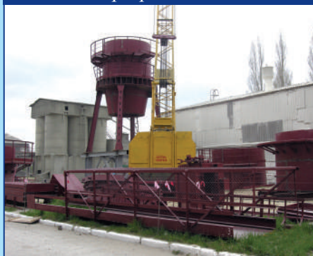
Монтаж газовапнякової печі в м. Суми
