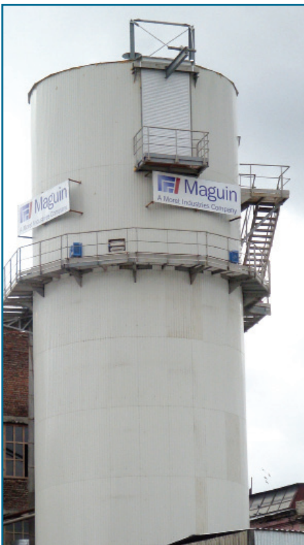
Рис. 2. Колонний дифузійний апарат, який поставлено фірмою «MAGUIN» та змонтовано фірмою «ТЕПЛОКОМ» на Жердевському цукровому заводі
