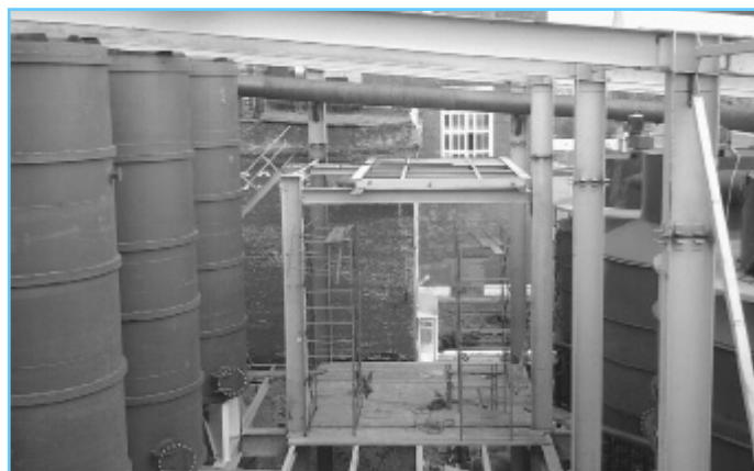
Підготовка майданчика для установки утфелерозподільника (03.08.2013)
