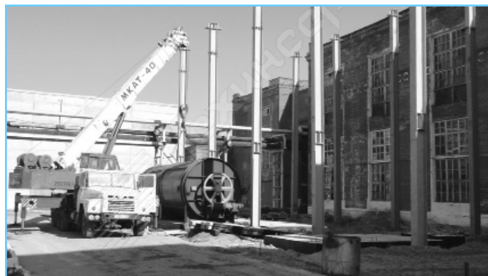
Монтаж першого обладнання – приймальна мішалка утфелю (03.06.2013)
