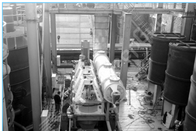
Монтаж утфелерозподільника і центрифуг (13.08.2013)
