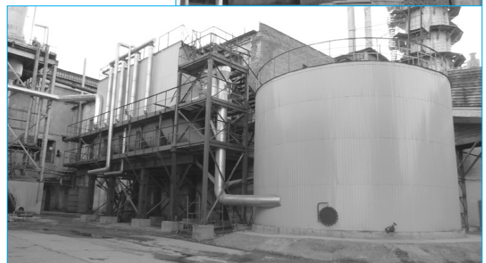
Станція очищення соку, 7000 тонн буряків за добу, Салівонківський цукровий завод
