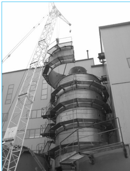
Монтаж дифузії на Черемновському цукровому заводі
