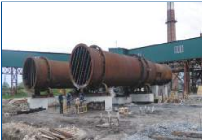
Монтаж жомосушильних барабанів
