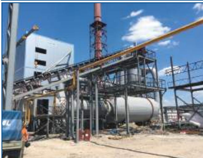
Монтаж жомосушильного комплексу
