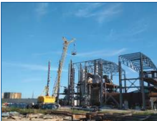
Монтаж металоконструкцій
