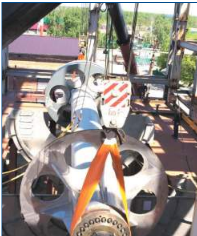
Монтаж барабана для сушки цукру «Fives-Cail»
