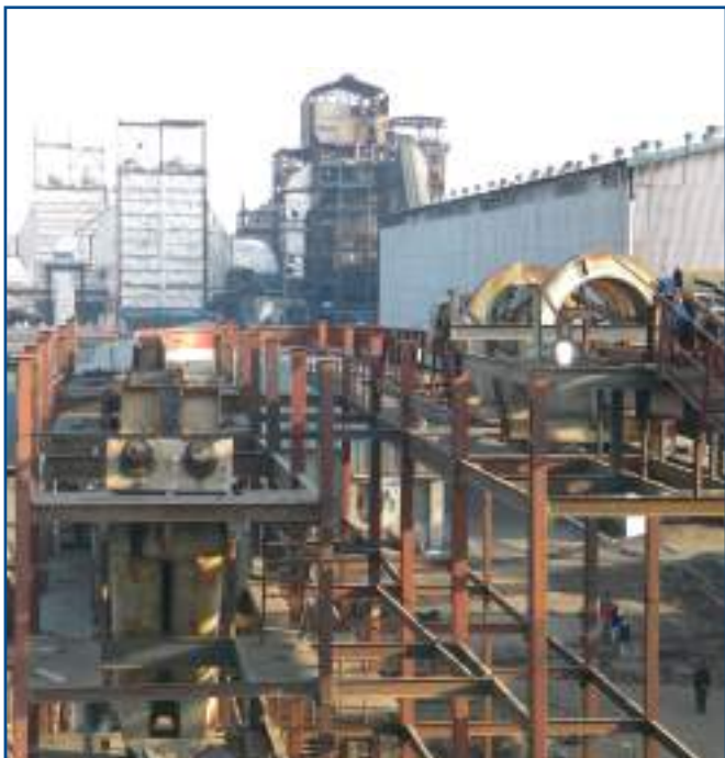
Процес установки компанією «Сахавтомат» металоконструкцій. початок установки технологічного обладнання
