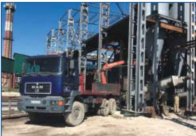
Монтаж транспортного обладнання
