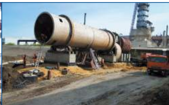
Монтаж жомосушильного барабану
