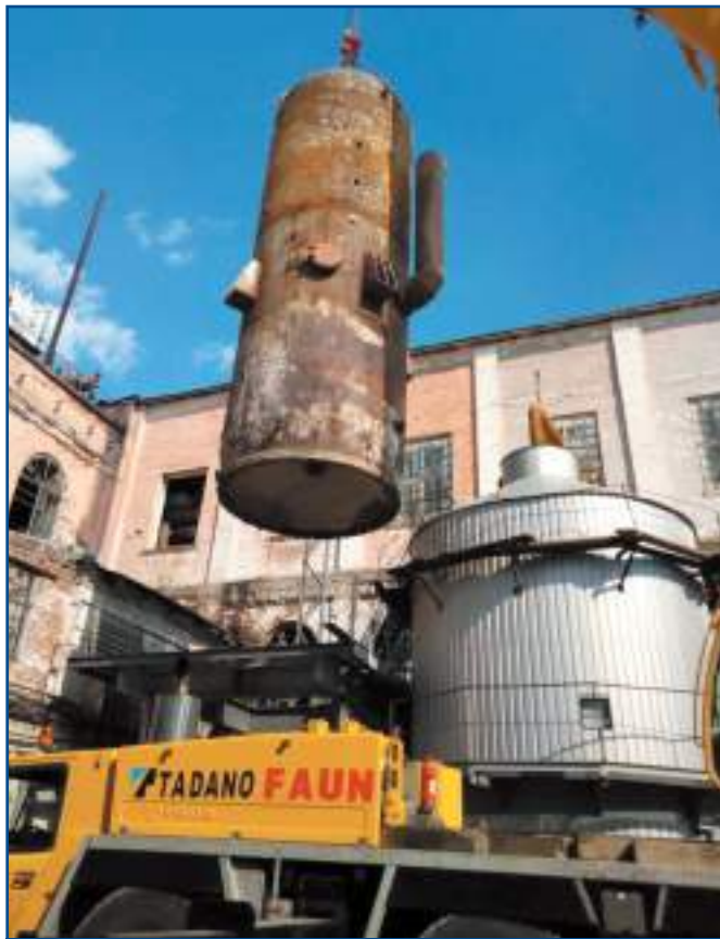
Монтаж випарного апарата
