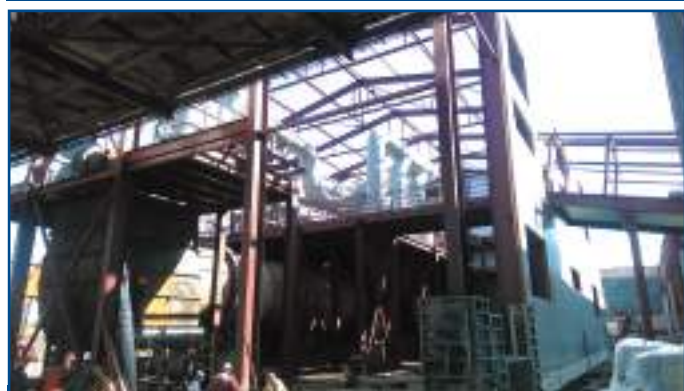
Монтаж обладнання жомосушильного відділення
