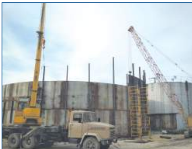
Монтаж ємності для зберігання меляси
