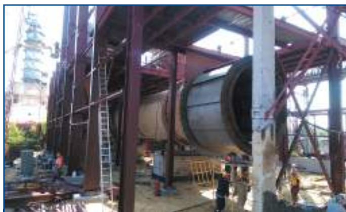
Монтаж розвантажувальної камери
