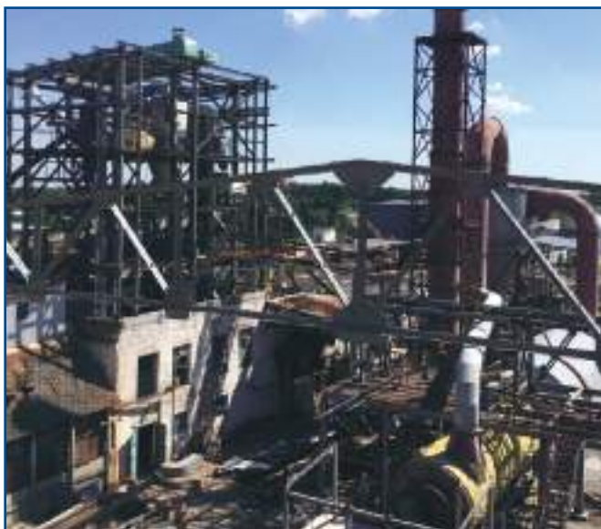
Монтаж жомосушильного комплексу
