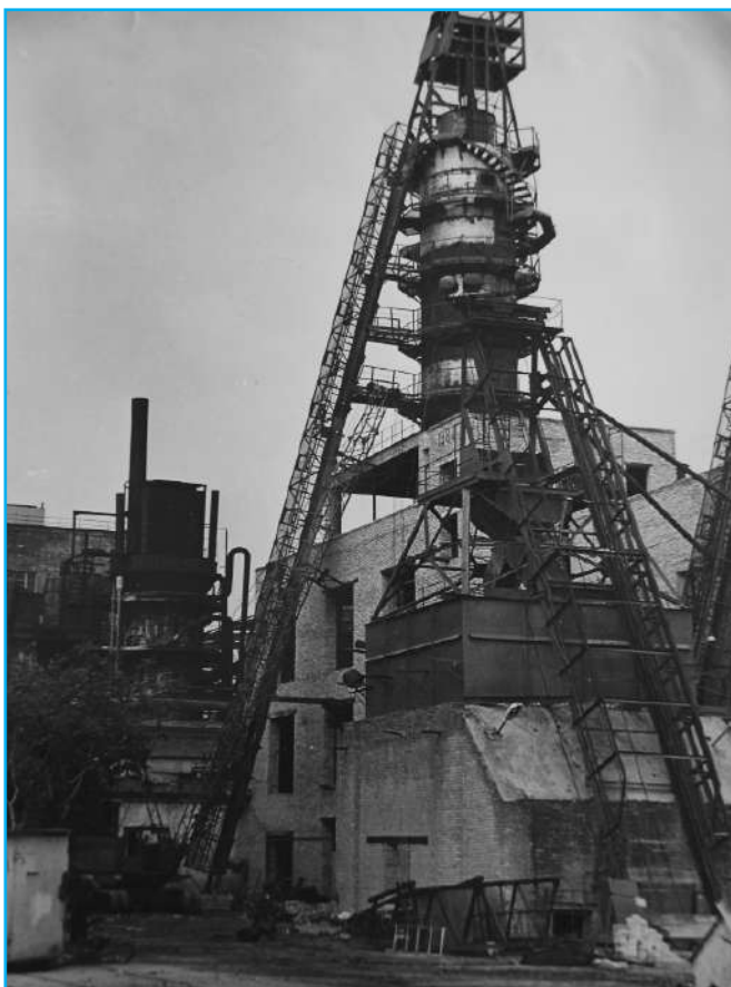
Газова піч на мазуті (Яготинський цукровий завод)
