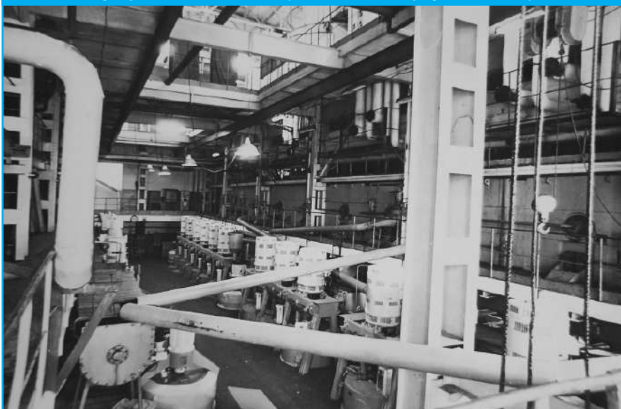
Випарна станція (Яготинський цукровий завод)
