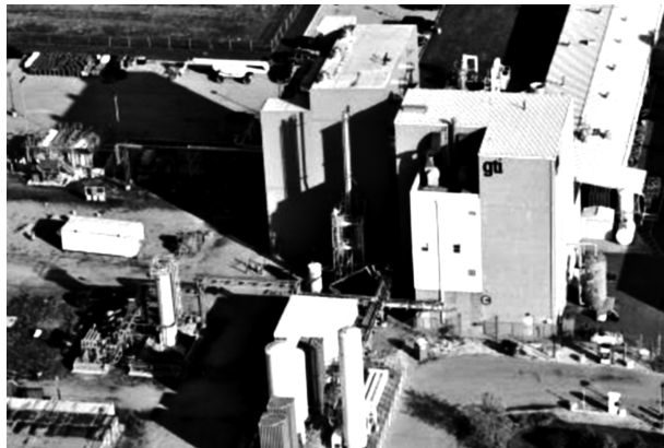
Общий вид пилотной установки по получению СМТ в Институте газовых технологий (США).
