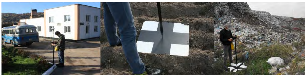
Рис. 7. Видгляд опорних точок у різних частинах полігону Fig. 7. Marking down in some part of the landfill
