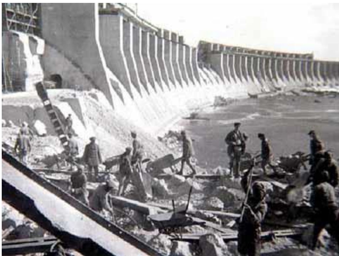
Рис. 2. Будівництво Дніпрогесу, 1930 р.
