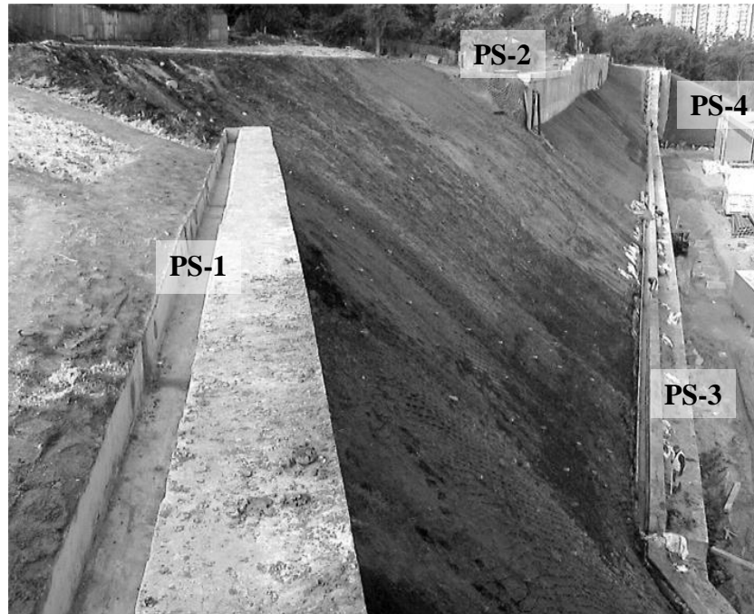
Рис. 1. Загальний вигляд розміщення підпірних
