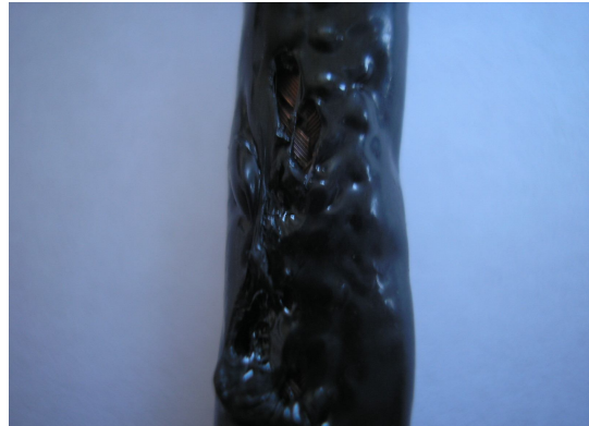
Рисунок 15 – Фотографія деградації зовнішньої ізоляції коаксіального кабелю РК-75-4-11, що знаходиться в високопровідному ґрунті після впливу МЭМИ
