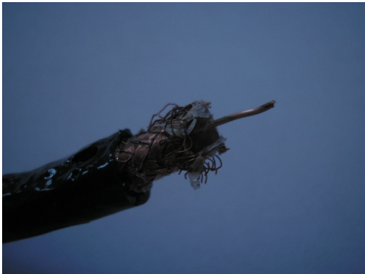
Рисунок 14 – Фотографія загальної деградації коаксіального кабелю РК-75-4-11, що знаходиться в високопровідному ґрунті після впливу МЭМИ
