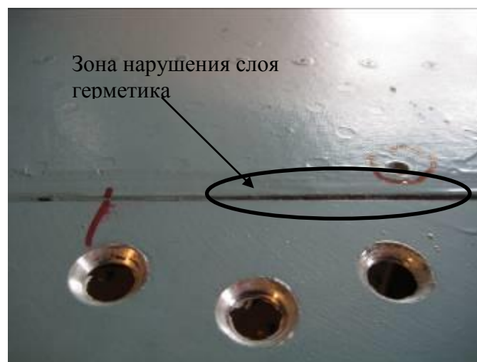
Рисунок 6 – Место стыка панели кия и стыковочной ленты крепления кия к подкилевой надстройке
