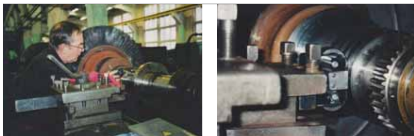
Рис. 12. Ремонт ротора турбокомпрессора ГТТ – 3 методом ЭЭЛ (а) с последующим ППД (б)
