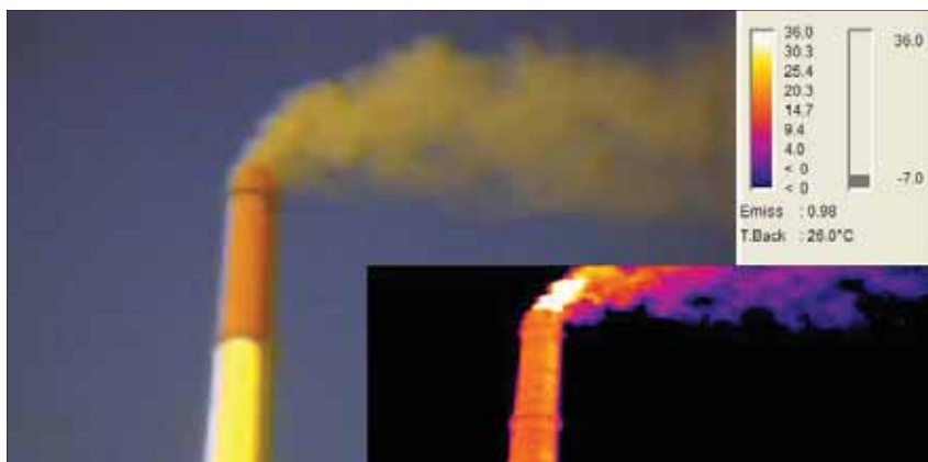
Рис. 3. Фото трубы ТЭС и ее термограмма
