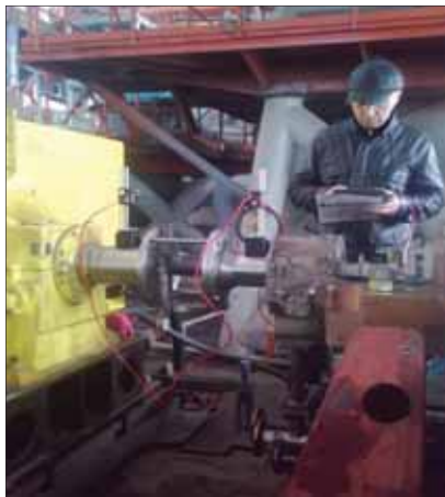
Рис. 1. Центровка конденсатного насосного агрегата АКсВА1500-120 с помощью лазерного прибора
