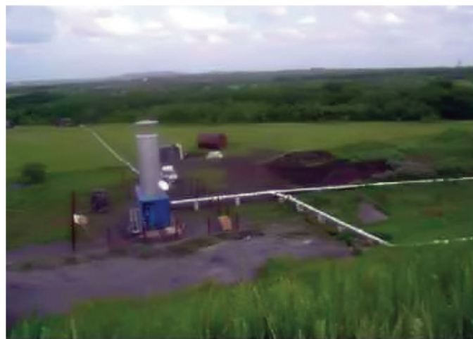
Рис. 4. Размещение установки УКГ на угольном месторождении
