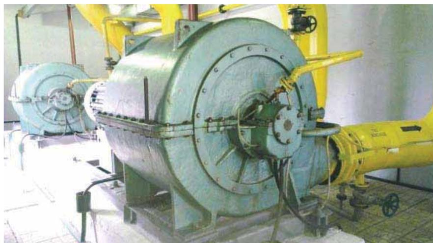
**Рис. 3. Газодувки коксового газа ГЦ-300/1,2У2 на газоповысительной станции Макеевского металлургического комбината**
