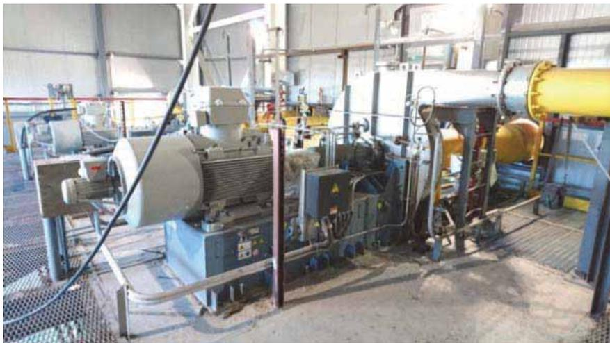
**Рис. 1. Установки компрессорные газовые центробежные ГЦ-270/1,18 У2 и ГЦ-170/1,18 У2 в составе «газоповысительной станции коксового газа»**
