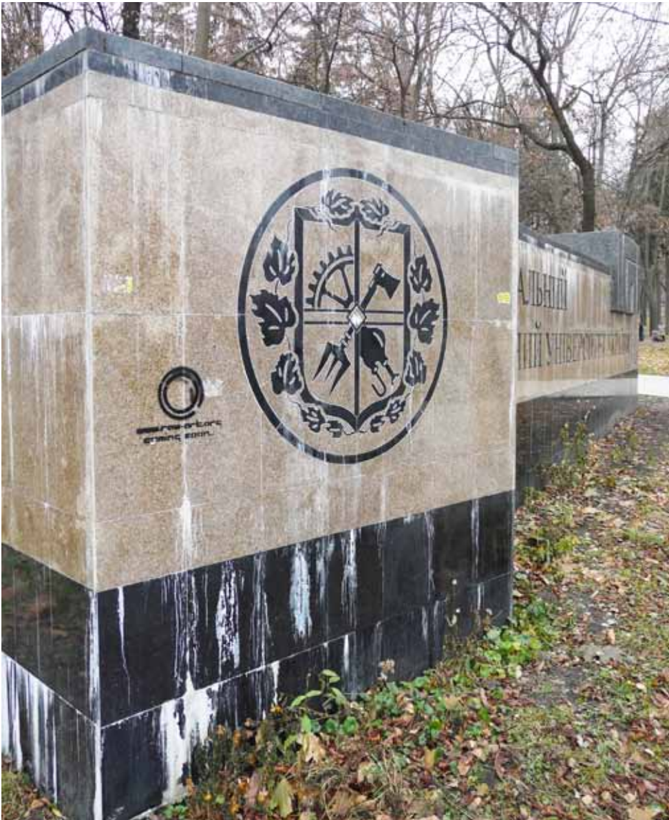
Рисунок 1. Комплексні пошкодження облицювання з граніту та габро (Київ): висоли, графіті, тріщини, зміна кольору
