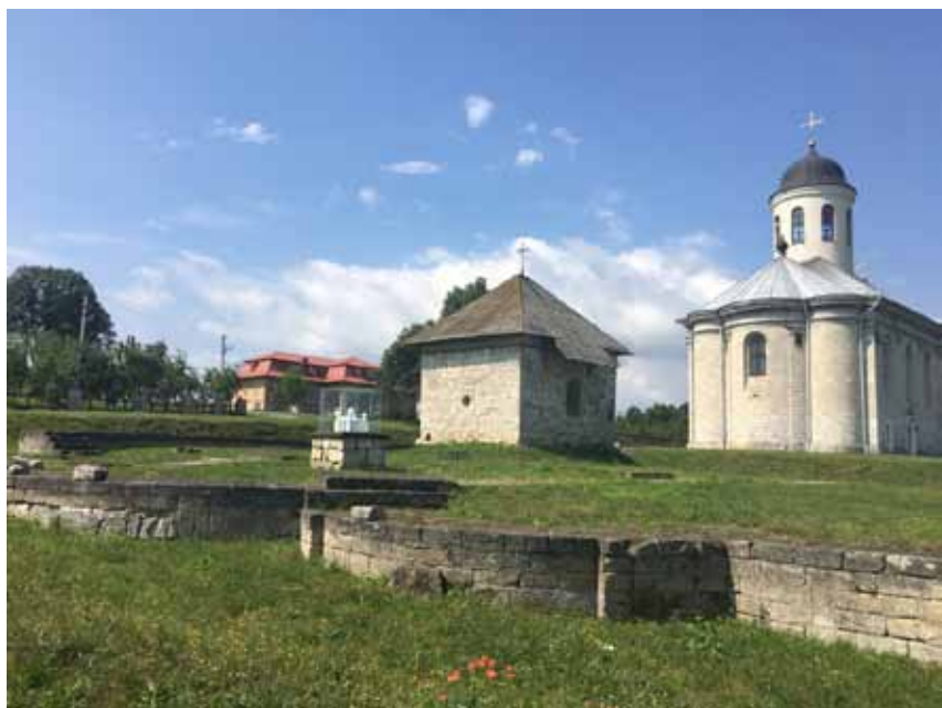
Рисунок 5. Тесані блоки з алебастру та вапняку у фундаменті Успенського собору в с. Крилос (Івано-Франківська обл.)
