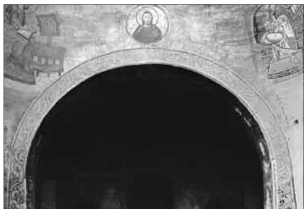
Гл. 27. Щока північної попружної арки центрального купола з реставраційною імітацією мозаїчного орнаменту на місці видаленого в 1953 р. напису XVII ст. Сучасний стан
