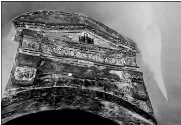
Гл. 25. Ліпний фронтон над аркою приділа Благовіщення із залишками поліхромії, після 1733 р. (північна зовнішня галерея). Сучасний стан
