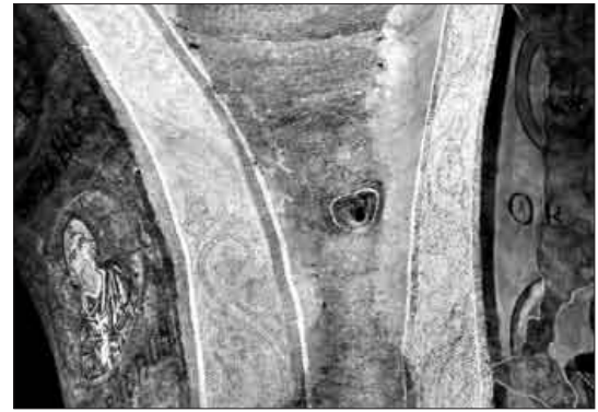
Іл. 29. П'яти південної та західної попружних арок центрального купола з реставраційною імітацією мозаїчного орнаменту на місці видаленого в 1953 р. напису XVII ст. Сучасний стан
