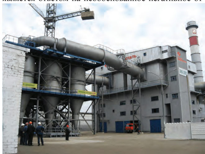
Рис. 2. Газоочистка В-3, В-5 разгрузочной зоны и линейных охладителей агломашин с площадью спекания 115 м 2 В ПАО «НЗФ»
